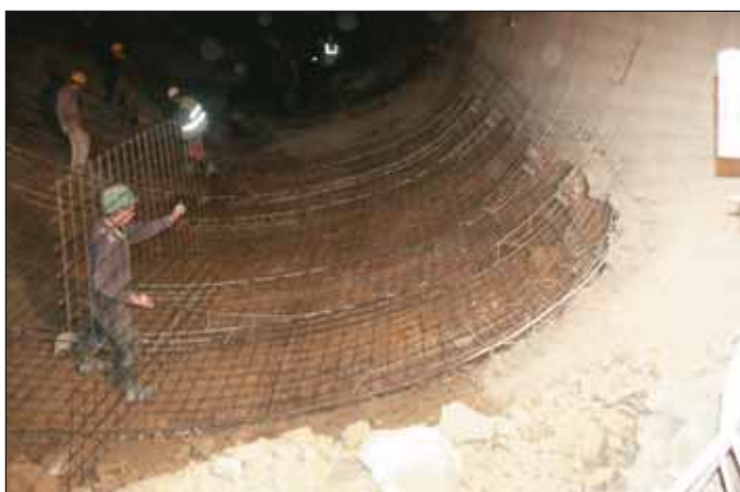
Obr. 3 Armování a uzavírání spodní klenby primárního ostění
