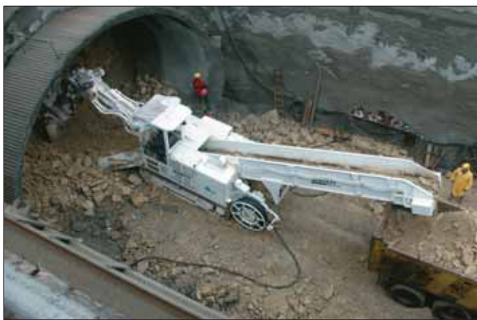
Obr. 2 Tunelbagr Schaeff ITC 312 před portálem při zahájení ražby od stanice Strážkov
