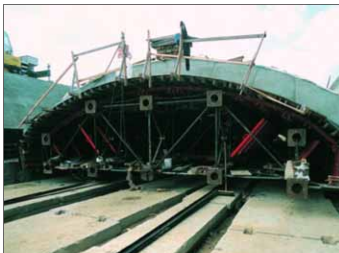
Obr. 3 Pohled na skruž Fig. 3 Vault scaffolding
