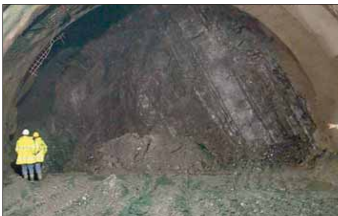
Obr. 5 Čelba tunelu u Vaux, vpravo je viditelná pískovcová vrstva Fig. 5 Tunnel face at Vaux showing Sandstone on the right
