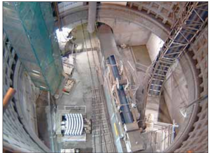
Obr. 11 Uspořádání startovací komory na PiccEx včetně dopravníku pro velké dopravní úhly
