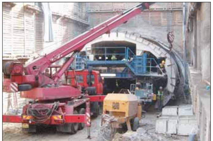
Obr. 5 Ocelová hydraulická forma Östu Stetin Fig. 5 Steel formwork Östu Stetin
