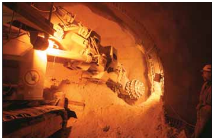
Obr. 1 Pohled na výložník s příčnou hlavou frézy Eickhoff 310 Q před raženou čelbou ve směru stanice Střížkov Fig. 1 A view of the boom with a cross-head of the EICKHOFF 380 Q roadheader, at the face of the excavation toward the Střížkov station
