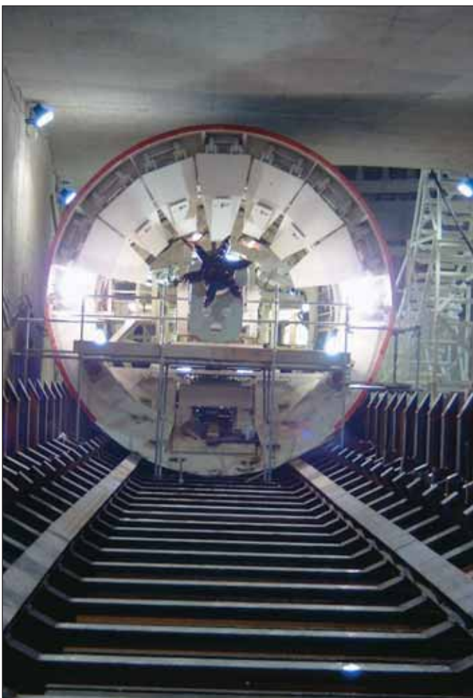
Obr. 12 Start štítu na HExEx
