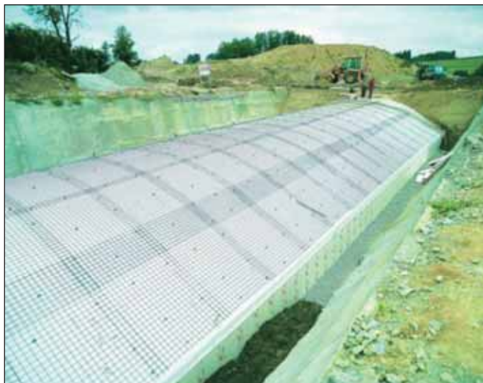
Obr. 4 Výztuž klenby Fig. 4 Reinforcement of the vault
