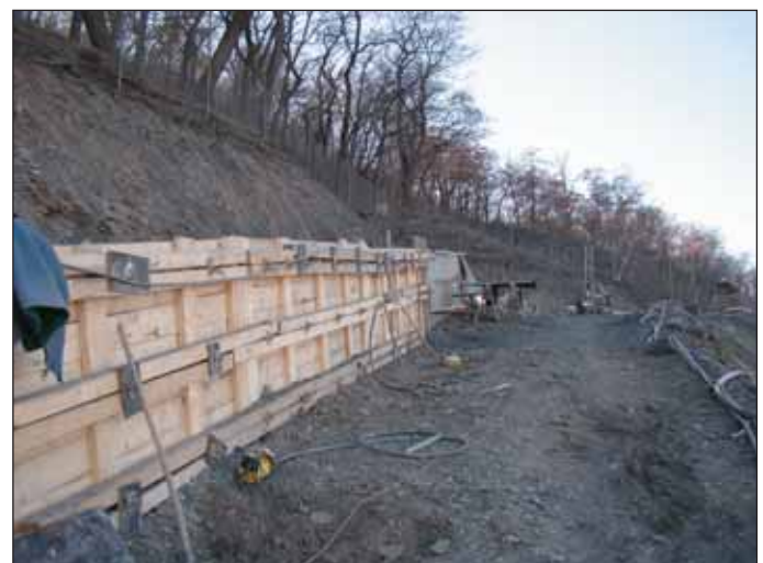
Obr. 5 Bednění věnce na úrovni 240 m n. m. Fig. 5 Formwork for the capping piece at 240 m a.s.l.
