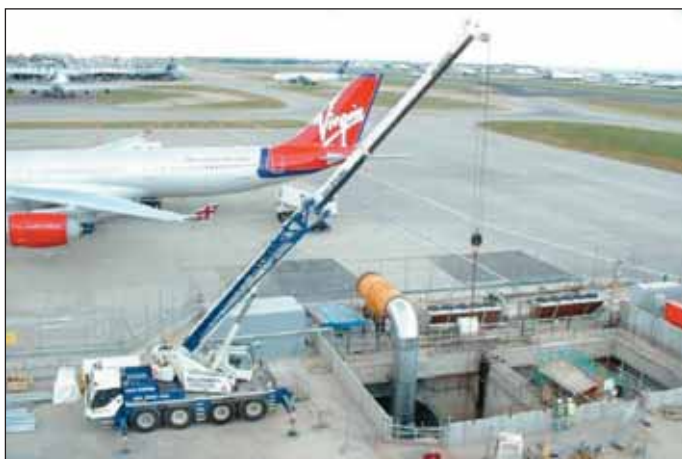
Obr. 2 Západní portál STLS umístěný v blízkosti provozovaného letiště Fig. 2 West Portal of the ART located close to the live airport
