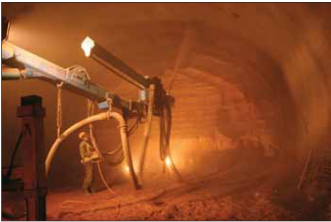
Obr. 4 Nanášení druhé vrstvy sřřkaného betonu pomocí manipulátoru Meyco – Potenza
