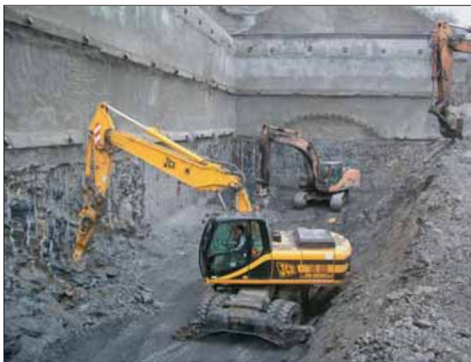
Obr. 7 Odtěžování a úprava povrchu stěn
