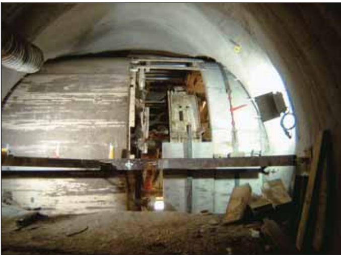
Obr. 10 Štít křížující propojovací chodbu vedoucí z šachty HExEx T5C (montáž šroubovaného skládaného ostění)
