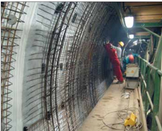
Obr. 6 Montáž výztuže definitivního ostění Fig. 6 Final lining reinforcement installation
