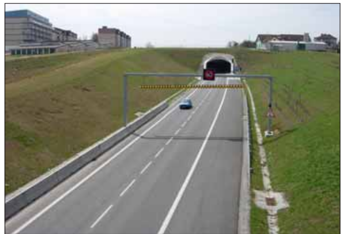
Obr. 7 Úsek silnice I/38 s hloubeným tunelem po uvedení do provozu Fig. 7 The I/38 road section with the cover-and-cut tunnel open to traffic
