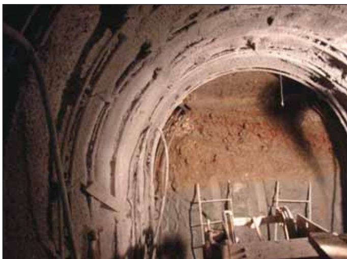
Obr. 6 Pohled na čelbu s rozhraním geologických vrstev Fig. 6 View of the face with the interface of geological layers
