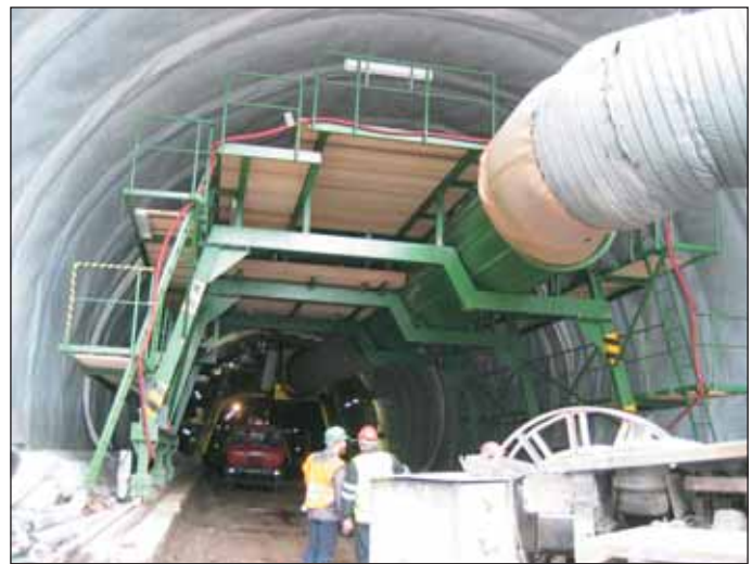
Obr. 5 Montážní plošina před zasunutím do tunelu Fig. 5 Assembly platform prior to entering the tunnel
