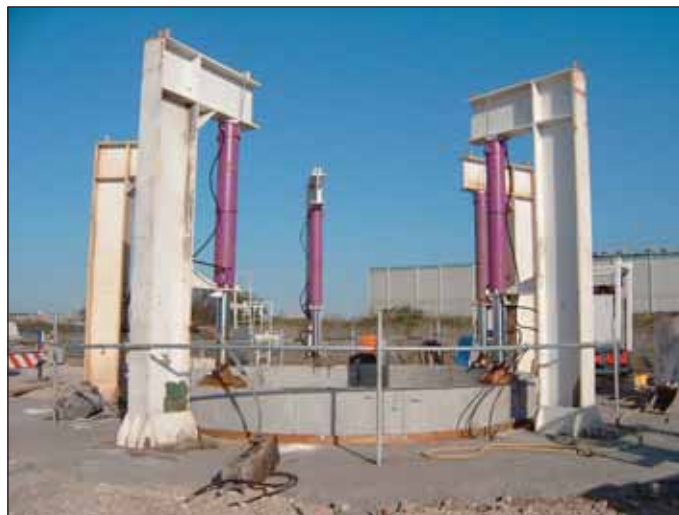
Obr. 5 Hloubení mezilehlé šachty 2 na TODV kesonováním Fig. 5 Caisson lowering for the SWOT Intermediate shaft 2
