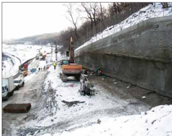
Obr. 6 Kotvení na úrovni 232 m n. m.
