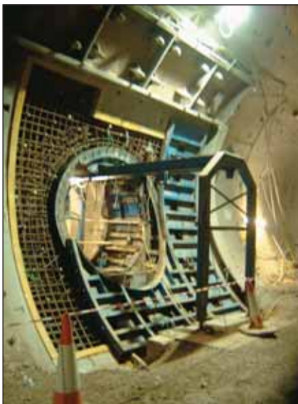
Obr. 4 Montáž bednění pro propojovací chodbu v STLS
