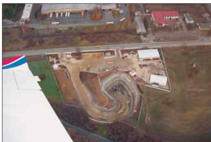
Obr. 6 Letecký pohled na stavební dvůr Klíčov s přístupovou štolou k čelbám tunelu pro ražbu do stanice Letňany a Prosek
