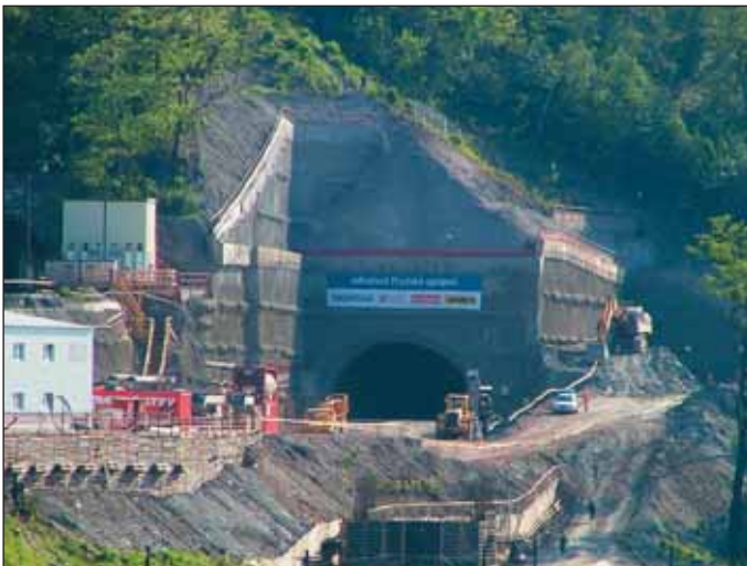
Obr. 1 Celkový pohled na portál Fig. 1 Overall view of the portal
