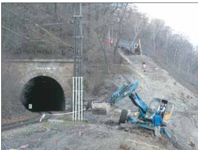
Obr. 4 Zahájení prací Fig. 4 Works commencement
