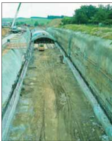
Obr. 1 Základy a stěny hloubeného tunelu
