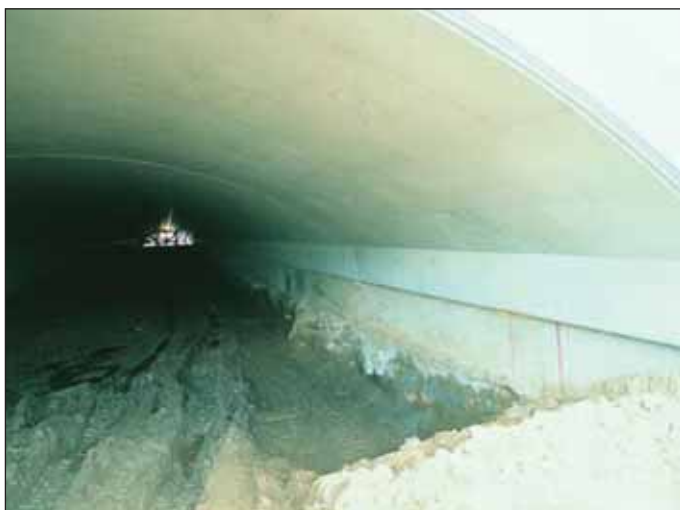
Obr. 5 Odbedněný povrch klenby Fig. 5 Stripped vault concrete surface
