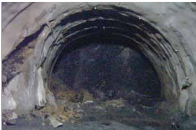
Obr. 8 Problémy při ražení poruchovou zónou Magnée Fig. 8 Incident during drive through Magnée fault
