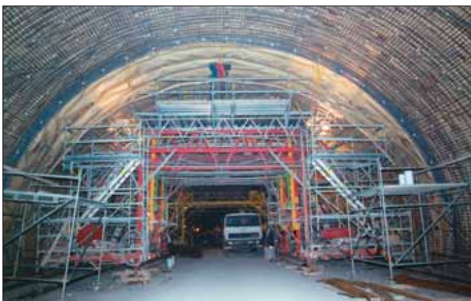
Obr. 2 Montáž výztuže z ukládacího vozu Fig. 2 Installation of reinforcement from the transportation vehicle
