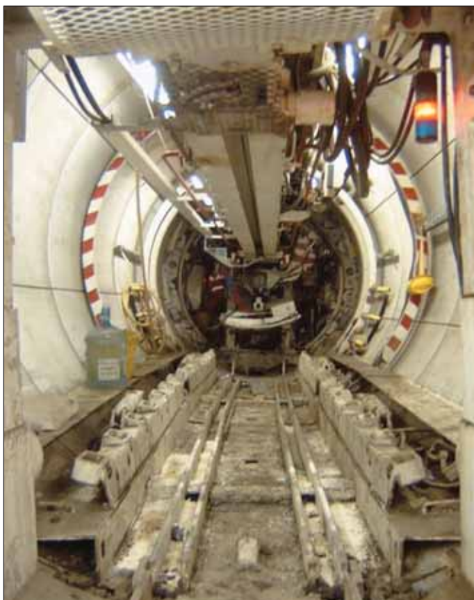
Obr. 7 První portálový jeřáb za tunelovacím strojem sloužící pro vykládání dílců z vozů při ražbě TODV
