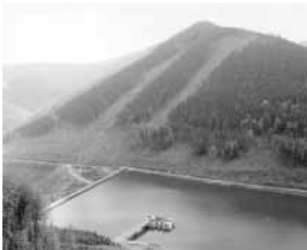
Obr. 6 Dolní nádrž Přečerpávací vodní elektrárny Dlouhé Stráně Fig. 6 Lower basin of the pumped-storage power plant Dlouhé Stráně
