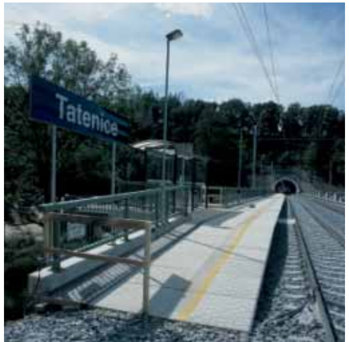
Obr. 2 Železniční stanice Tatenice mezi Krasíkovským a Tatenickým tunelem Fig. 2 Tatenice railway stop between Krasíkov and Tatenice tunnels
