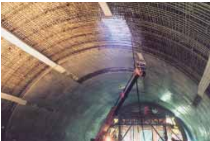
Obr. 12 Betonáž klenby definitivního ostění Fig. 12 Casting of the final lining vault
