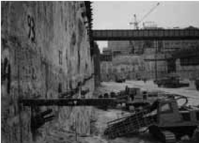
Obr. 3 Měřicí bod posunutí podzemní stěny na stanici A13 Fig. 3 Measuring point of diaphragm wall horizontal displacement at station A13
