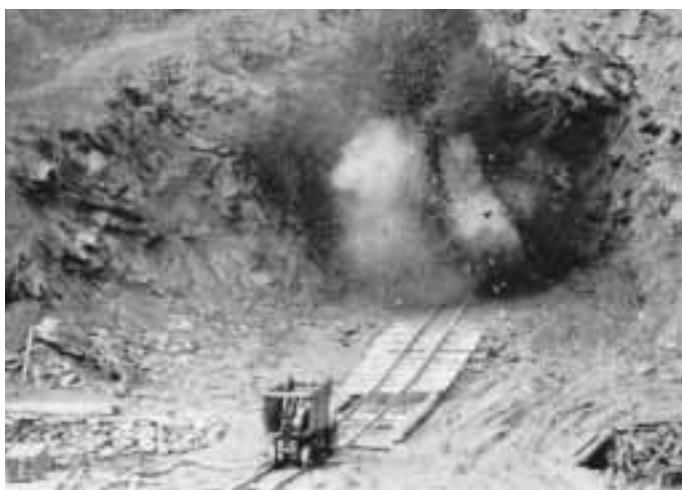
Obr. 1 Rok 1964, vodovodní přivaděč Želivka – první odpal na pokusné štolě Fig. 1 1964, water feeder Želivka – first blasting in the experimental gallery
