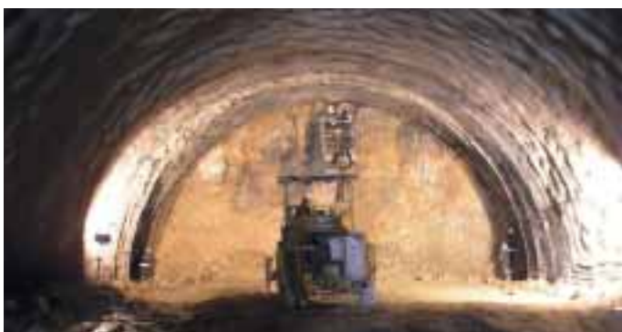
Obr. 5 Tunel Krasíkov I - ražba kaloty, montáž rámu BTX Fig. 5 Krasíkov I tunnel - top heading excavation, erection of BTX frame
