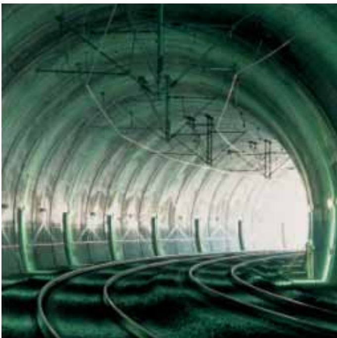
Obr. 3 Krasíkovský tunel Fig. 3 Krasíkov tunnel
