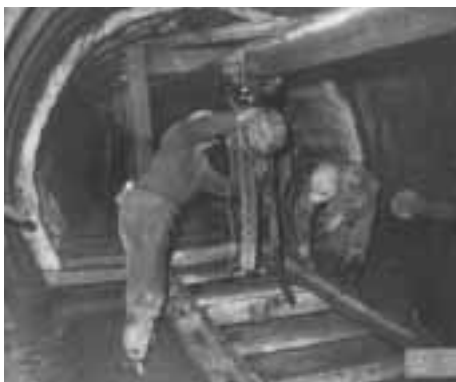
Obr. 3, 4, 5 Ražba vodovodního přívaděče Želivka Fig. 3, 4, 5 Excavation of the water feeder Želivka
