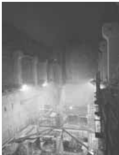
Obr. 7 Kaverna Přečerpávací vodní elektrárny Dlouhé Stráně Fig. 7 Cavern of the pumped-storage power plant Dlouhé Stráně
