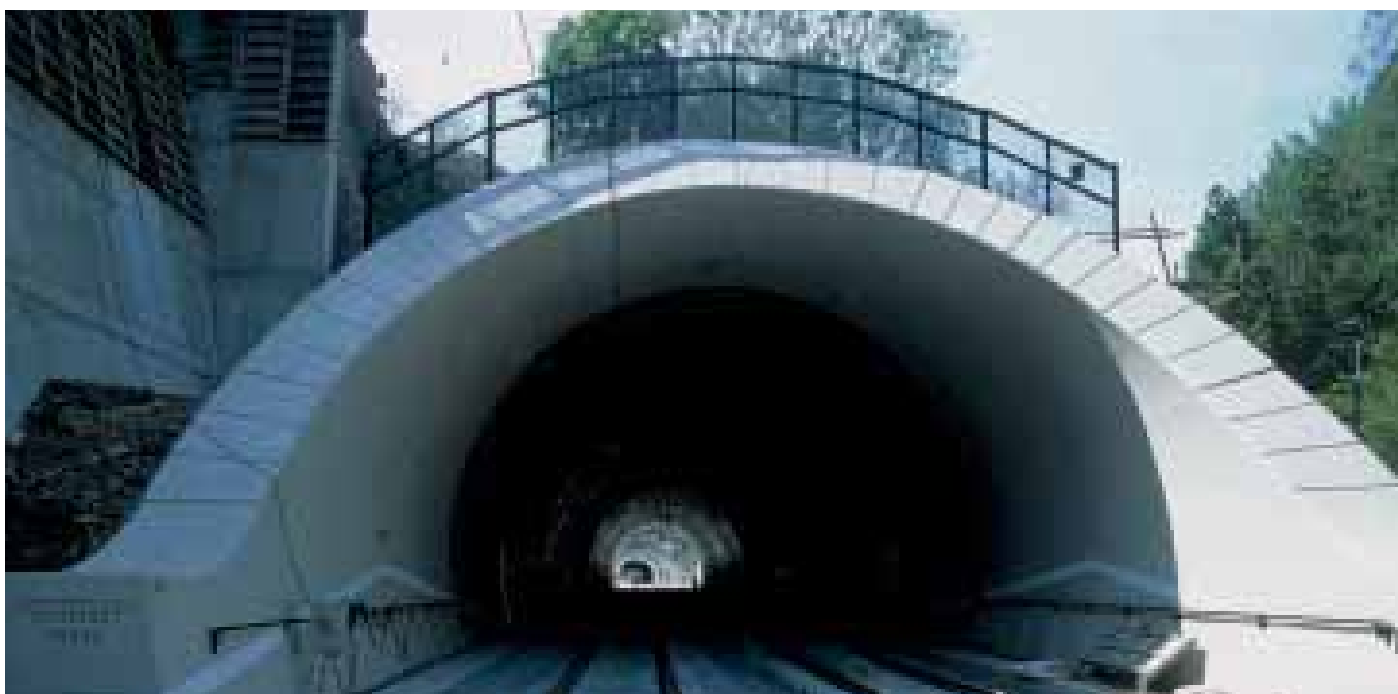
Obr. 1 Nový tunel Krasíkov 1 Fig. 1 Krasíkov 1 New tunnel
