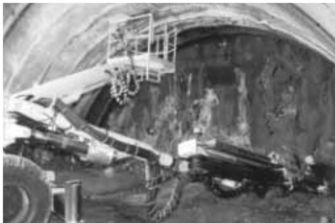
Obr. 9 Ražba silničního tunelu VMO na Pražské radiále v Brně Fig. 9 Excavation of the road tunnel on the city ring road Prague artery in Brno
