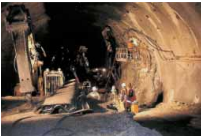
Obr. 6 Meranie 3D deformácií primárneho ostenia tunela a vytýčovanie prerážky UC-5 medzi tunelmi
