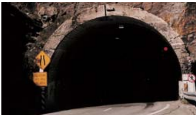
Obr. 3 Západní portál tunelu Homer Fig. 3 Western portal of the Homer tunnel
