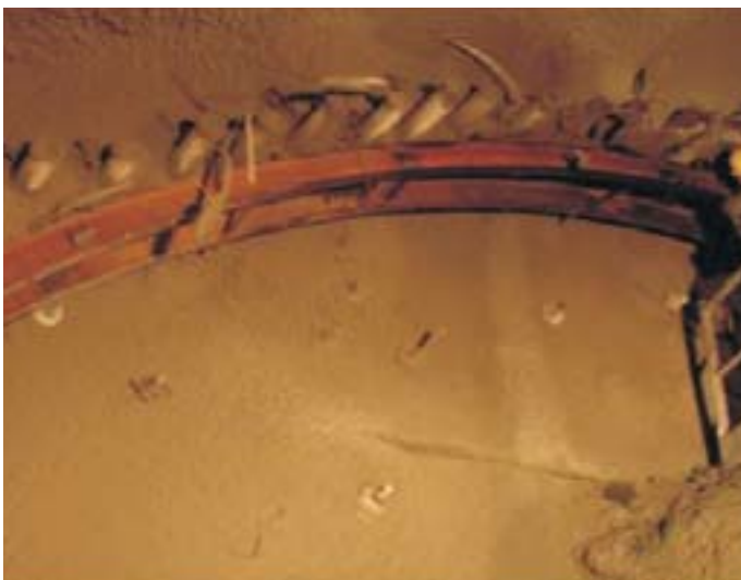
Obr. 2 Budovanie výstuže vo vstrojovacej triede SCC II, typ 18 Fig. 2 Support erection in the excavation class SCC II, type 18
