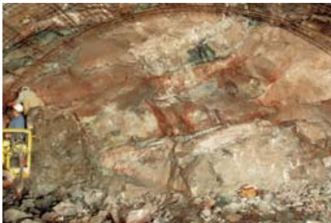
Obr. 7 Montáž výztuže primárního ostění Fig. 7 Installation of reinforcement of primary lining
