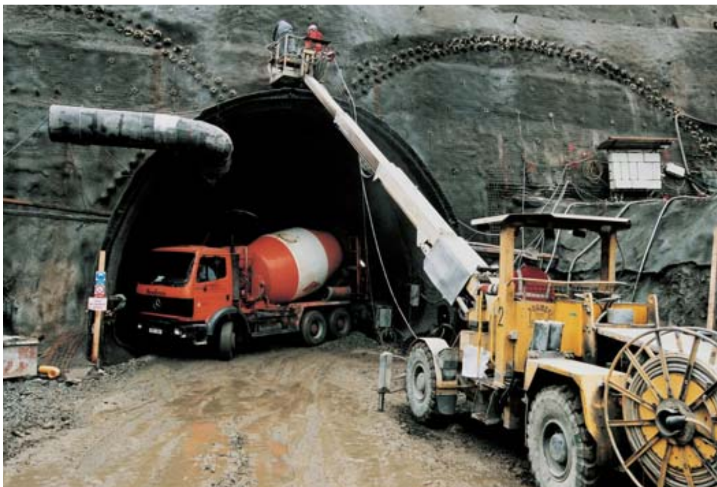
Obr. 2 Portálová stěna tunelu Valík Fig. 2 Portal of Valík tunnel
