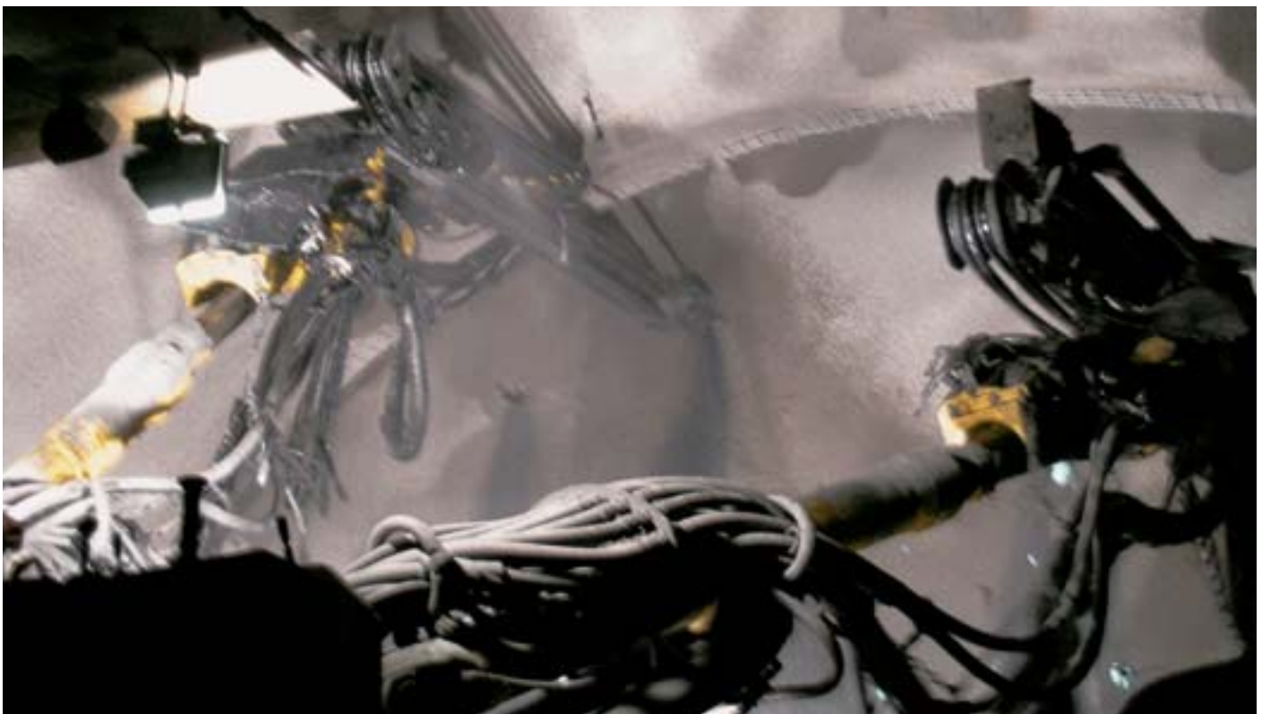
Obr. 3 Meranie deformácie horninového masívu počas priebehu razenia s horizontálnym inklinometrom Fig. 3 Measurement of the rock mass deformation with horizontal inclinometer during excavation
