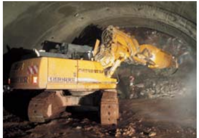
Obr. 4 Profilování výrubu pásovým tunelbagrem Liebherr LR 934 Fig. 4 Excavation profiling by Liebherr LR 934 tunnel excavator
