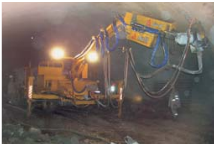
Obr. 6 Provádění stříkaného betonu - manipulátor Aliva AL 500 a stříkací stroj AL 285 Fig. 6 Application of shotcrete - Aliva AL 500 robot and AL 285 spraying machine
