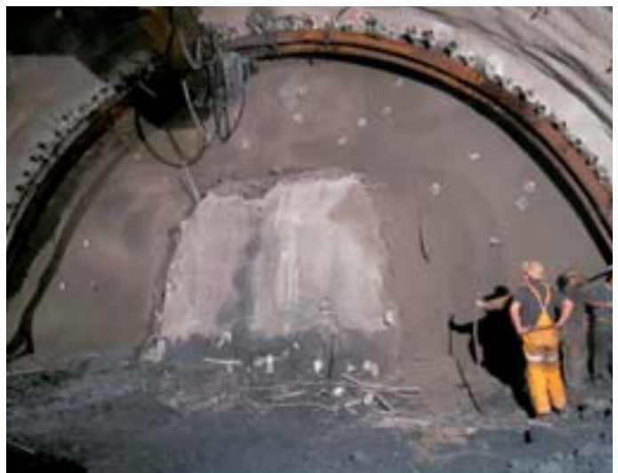
Obr. 2 Budovanie výstuže vo vstrojovacej triede SCC II, typ 18 Fig. 2 Support erection in the excavation class SCC II, type 18
