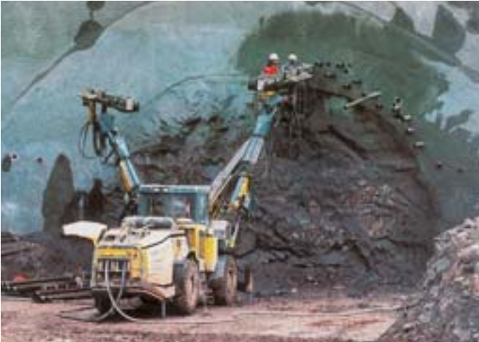
Obr. 2 Zajištění příportálového úseku - vrtání mikropilotového systému Bodex Fig. 2 Portal section support - drilling for the Bodex canopy tube pre-support
