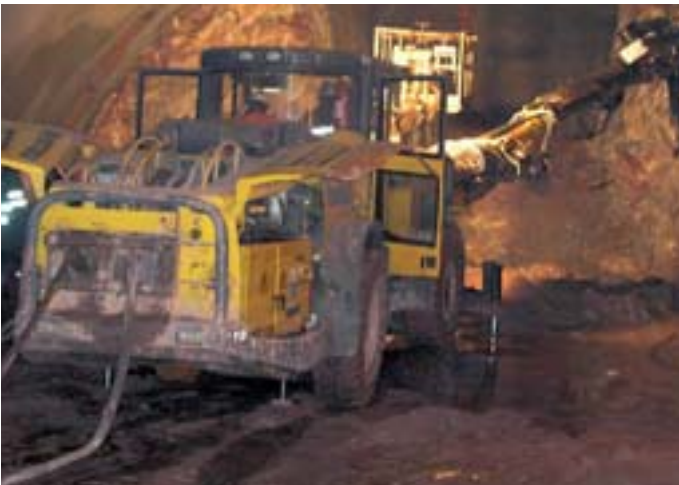
Obr. 3 Vrtání pro trhací práce - vrtný vůz Atlas Copco AC L2C Fig. 3 Drilling blast holes - Atlas Copco AC L2C drill rig
