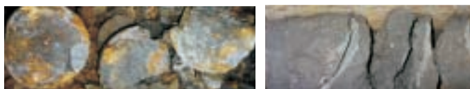
Obr. 9 Vrtné jádro z kontrolního vrtu v Příbrami, proinjektovaný zásyp injektážní PC směsí a výplňová PC směs ze zaplněné dutiny Fig. 9 Boring core from the checking bore in Příbram, the backfill grouted using the PC mixture and the backgrouting PC mixture from the filled cavity
