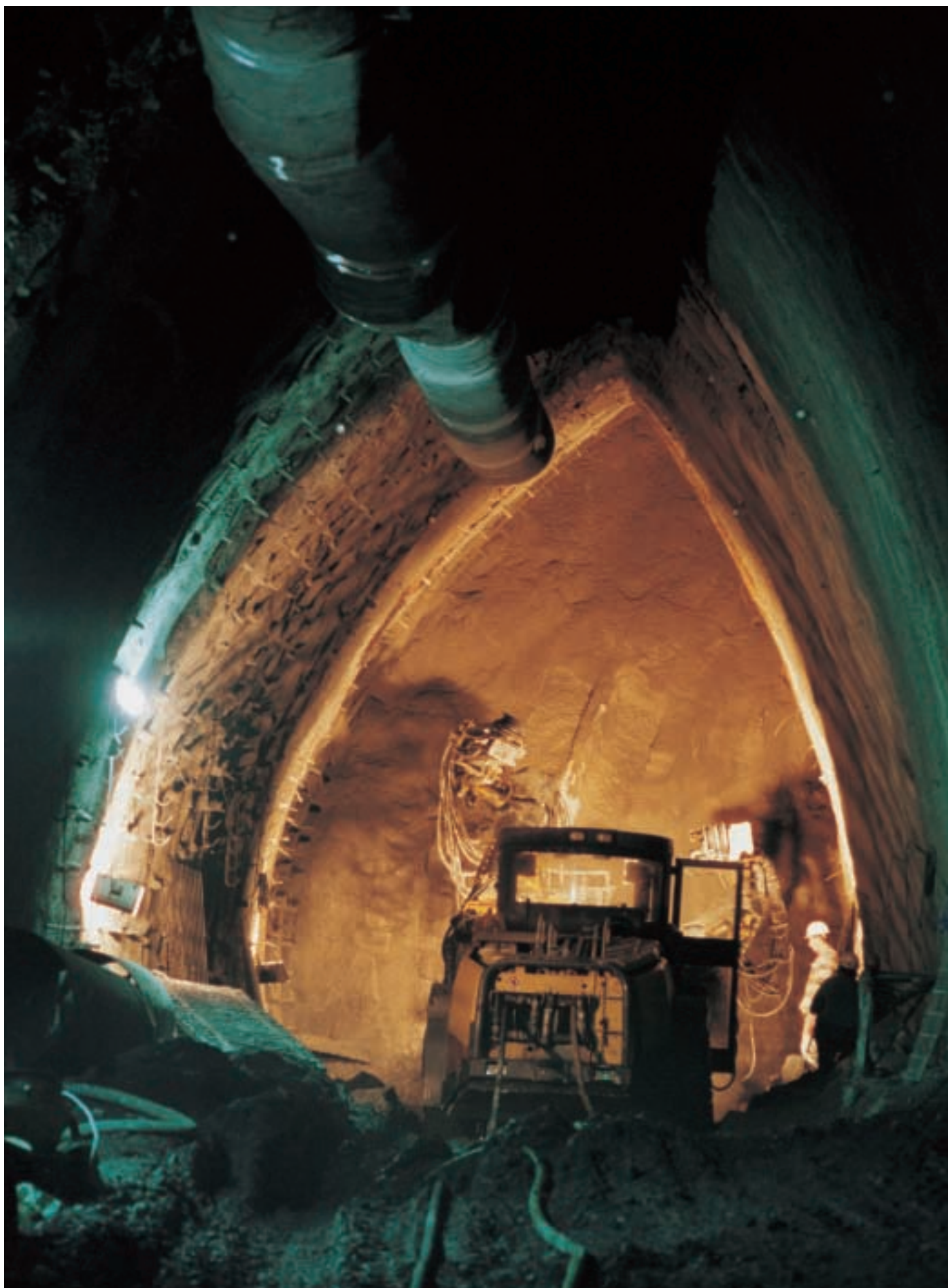
Obr. 8 Vrtací práce na čelbě bočního tunelu v členěném výrubu stanice Kobylisy Fig. 8 Drilling the face of the side-wall drift as a part of the sequential excavation of the Kobylisy station
