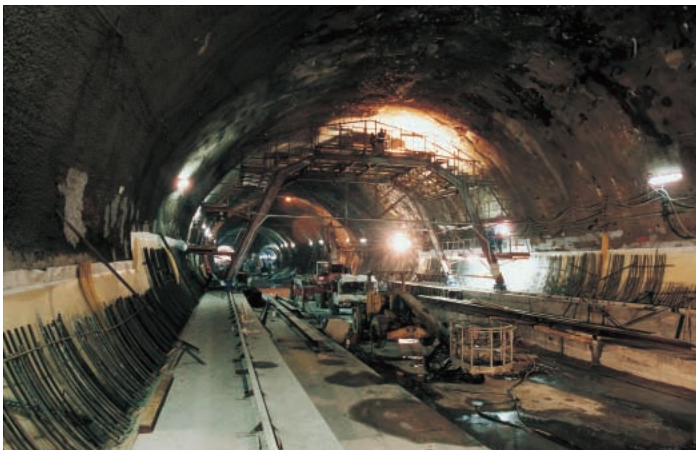
Obr. 10 Tunel stanice po betonáži spodní klenby, instalace izolačních folií Fig. 10 Application of waterproofing membrane after completion of the invert
