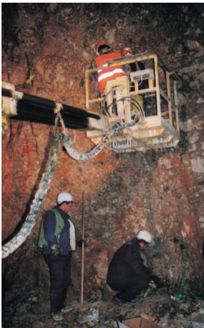
Obr. 2 Trhací práce na čelbě Fig. 2 Blasting works in the heading
