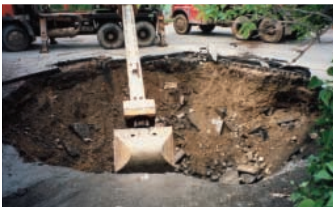
Obr. 1 Propad silnice I/18 v Příbrami naproti zdravotnickému středisku Fig. 1 Subsidence of road I/18 in Příbram across the medical center
