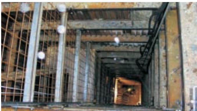
Obr. 13 Hloubení jámy s odtěžováním rubaniny v okovu a pomocí drapáku s průběžným zajišťováním stěn jámy ocelovou výztuží s ocelovým pažením, ocelové rámy v kroku 1,0 m, hloubka 16 m Fig. 13 Sinking of the shaft with disposal of muck in a sinking bucket and using a grabber, with continuous support of the shaft walls by steel reinforcement with steel sheet bracing, steel frames every 1,0 m, depth of 16 m
