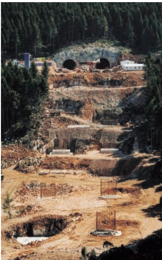
Obr. 1 Severní portál Fig. 1 North portal
