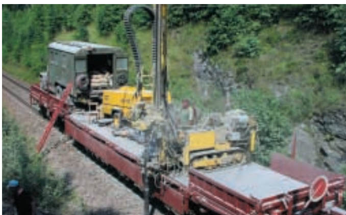
Obr. 2 Geotechnický vrtný průzkum rozsahu poddolování v podloží železniční tratě Plzeň – Cheb Fig. 2 Geotechnical boring exploration of the extent of undermining underneath the railway track Plzeň – Cheb
