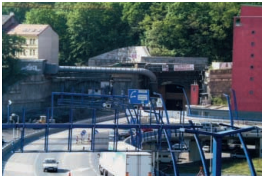
Obr. 1 Severní portál tunelu Mrázovka Fig. 1 Northern portal of the Mrázovka tunnel
