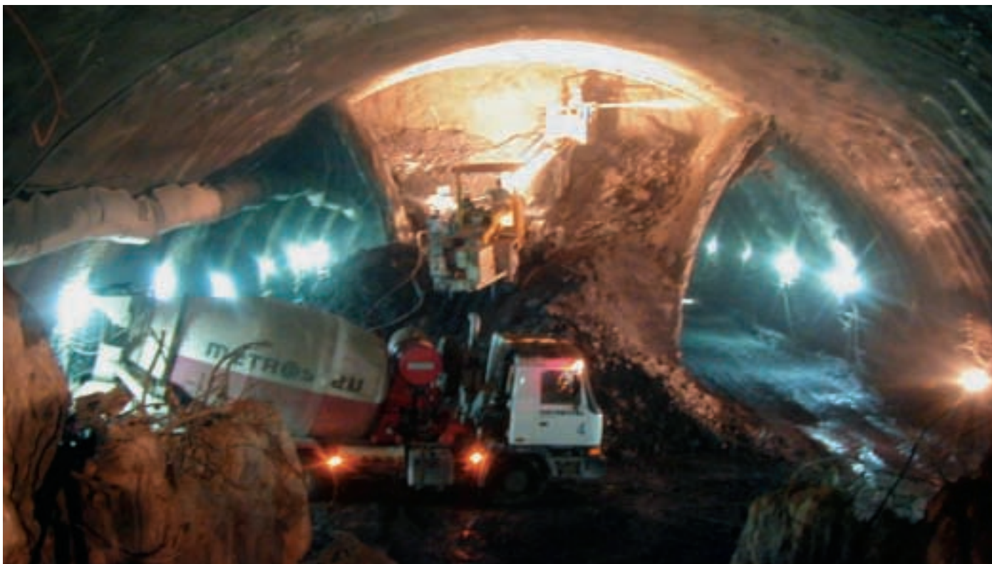
Obr. 2 Pohled na ražbu při vertikálním členění výrubu Fig. 2 Excavation at the vertical sequencing
