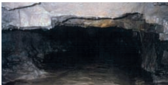
Obr. 7 Pohled do ze 3/4 zaplněných důlních děl zpevněnou směsí na bázi popílku, podloží křižovatky v obci Lukavice Fig. 7 View into mining structures up to 3/4 filled with consolidated mixture of fly ash underneath a road crossing in village of Lukavice
