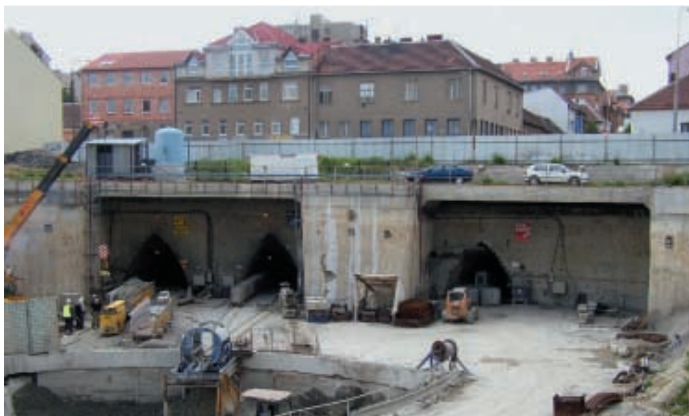
Obr. 1 Pohled na provizorní portál (začátek průzkumných štol) Fig. 1 Temporary portal (the beginning of the exploration galleries)
