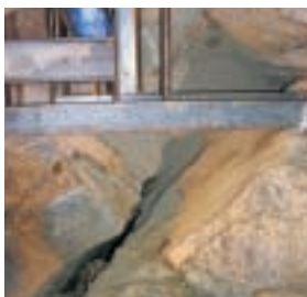
Vlevo: Obr. 11 Rozevřené průběžné tahové trhliny ověřené při hloubení jámy Left: Fig. 11 Open running tension fractures, verified during the ditch excavating
