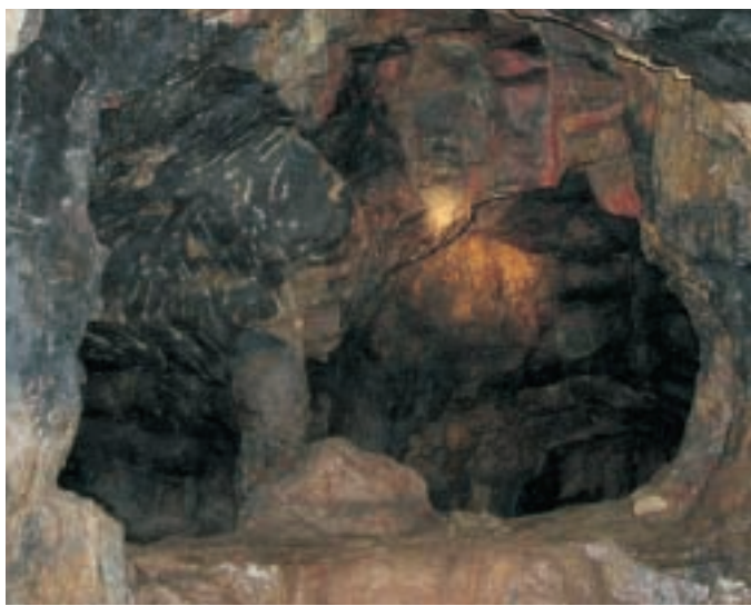
Obr. 15 Původní komorové dobývání metodou „sázení ohněm“ (15. až 16. st.) s ponechaným mezikomorovým pilířem Fig. 15 Original chamber mining by means of fire (15th – 16th century) with a room fender maintained
