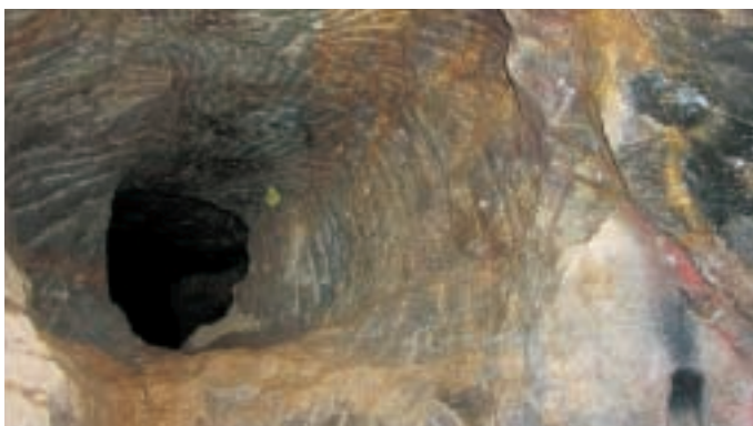
Obr. 14 Původní ručně ražená propojovací chodba mezi komorami se stopami po železkách a s výklenkem pro kahanec (15. až 16. st.) Fig. 14 Original manually excavated cross passage between chambers with traces of hack irons and a lamp niche (15th – 16th century)
