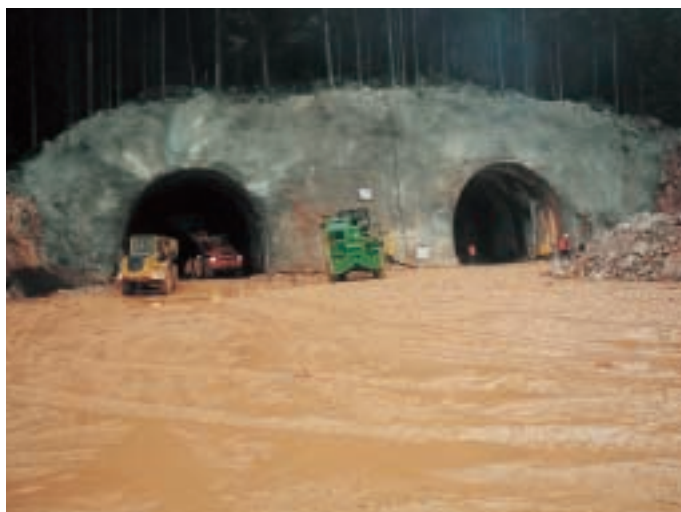
Obr. 4 Jižní portál – obě tunelové trouby Fig. 4 South portal – both tubes
