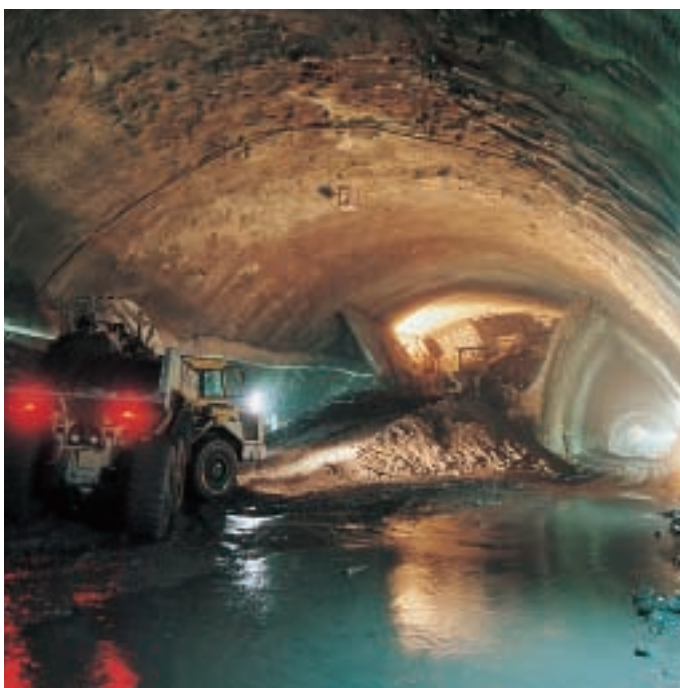
Obr. 6 Ražba střední části kaloty stanice Fig. 6 Excavation of the central part of the top heading
