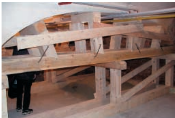
Obr. 4 Provizorní výdřeva klenby v suterénu objektu Fig. 4 Temporary timber support under the vault in a building basement
