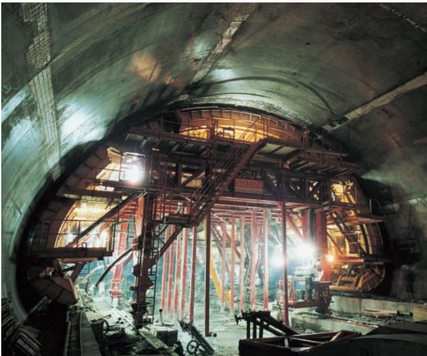
Obr. 11 Železobetonová klenba ostění stanice a pojezdňé bednění Fig. 11 Reinforced concrete vault and the traveller formwork
