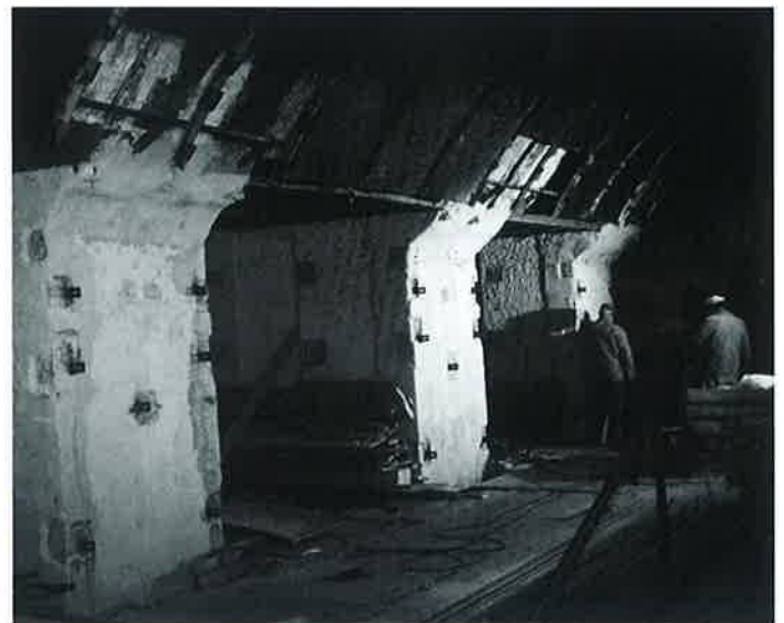
Obr. 2. Střední staniční tunel – oprava prostupů
