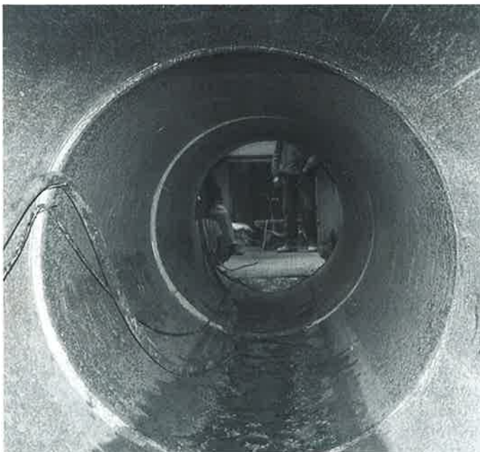
Obr. 2: Železobetonový protlak DN 1200 mm pod dálnicí D1 u Průhonice pro odkanalizování nově budovaného areálu
