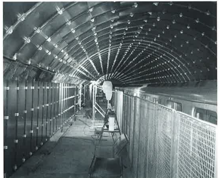
Obr. 4. Boční staniční tunel – průjezd vlaků metra stanicí
