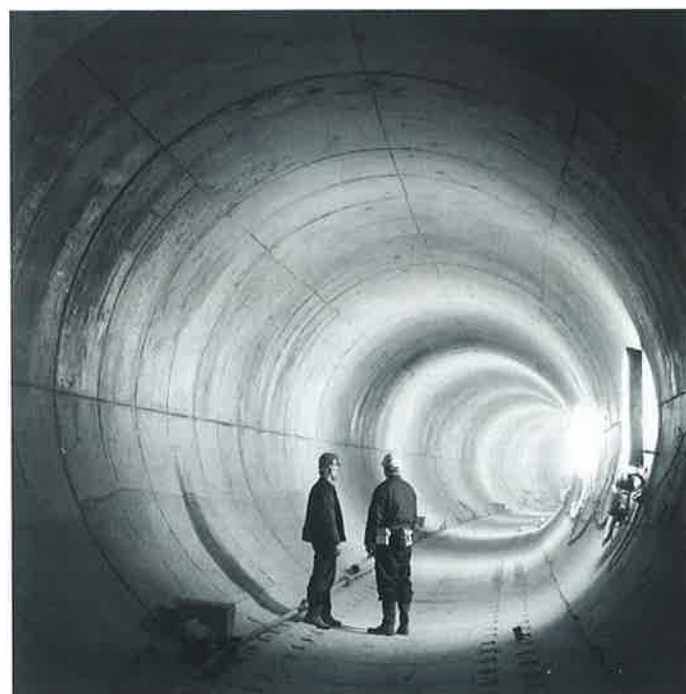
Obr. 3, 4: Zatěsněné litinové a železobetonové ostění traťových tunelů systémem Mediatan 701/Mediatan 36-1
