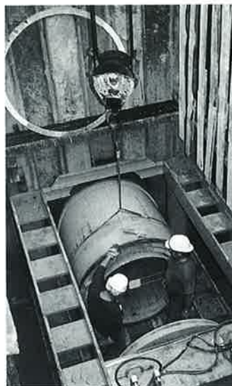
Obr. 1: Kanalizační sběrač Čáslav. Příprava na start štítu pro železobetonový protlak DN 1200 mm
