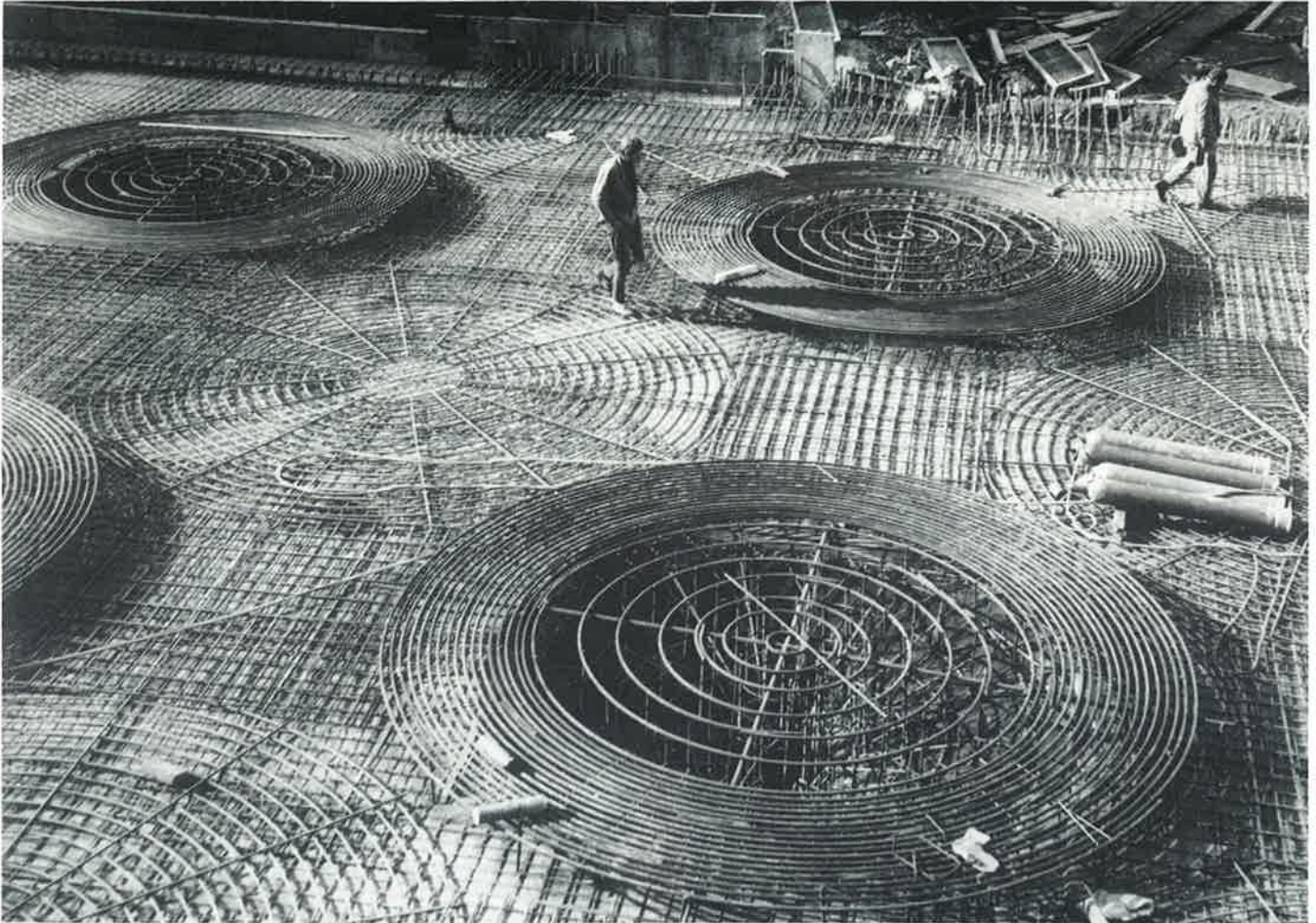
Pohled na položenou výztuž na stropě vestibulu stanice Muzeum
