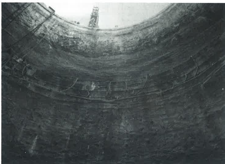
Pohled na sanování spodních vod pod milánskými stěnami
