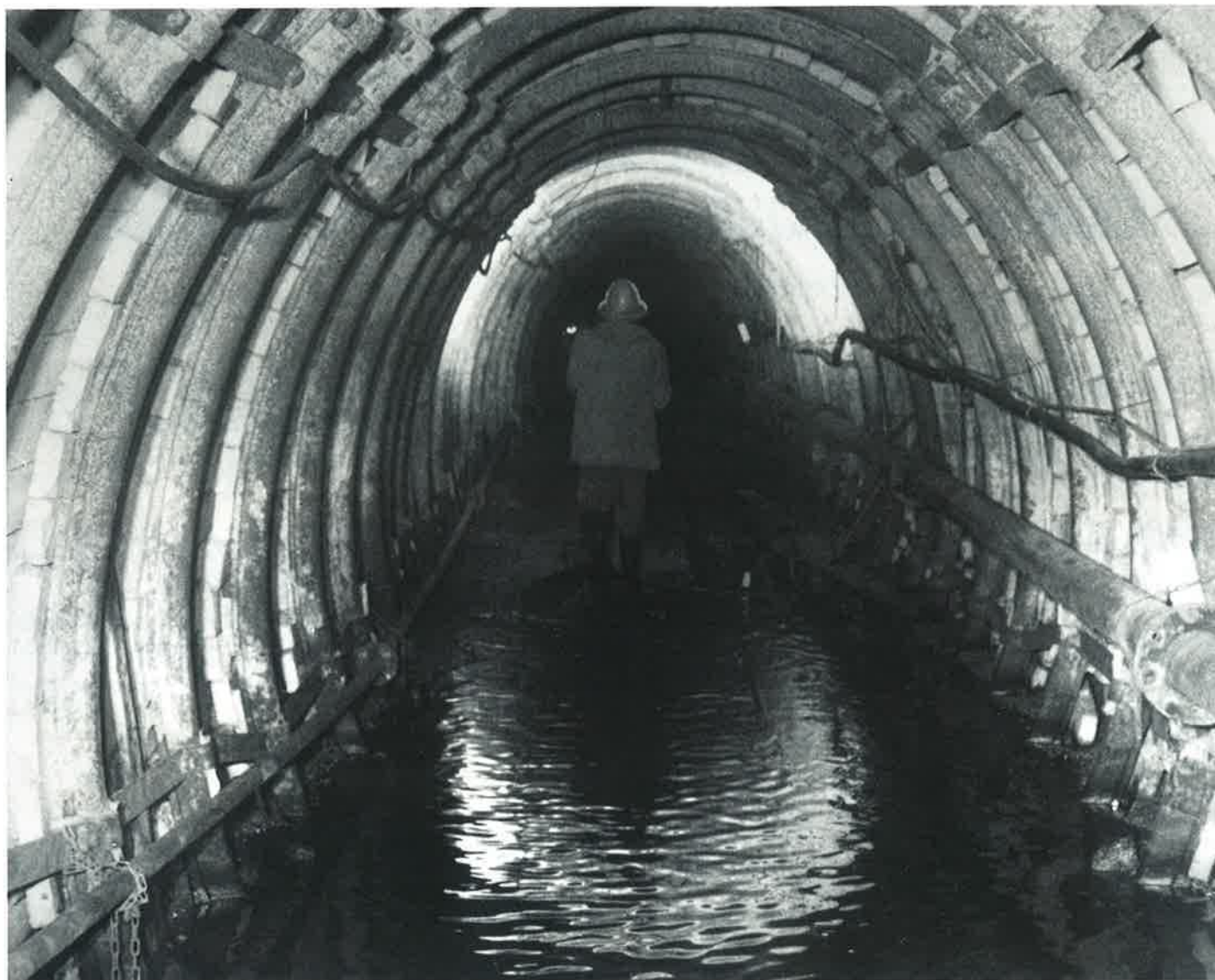
Vyražená štola s provizorní výztuží
